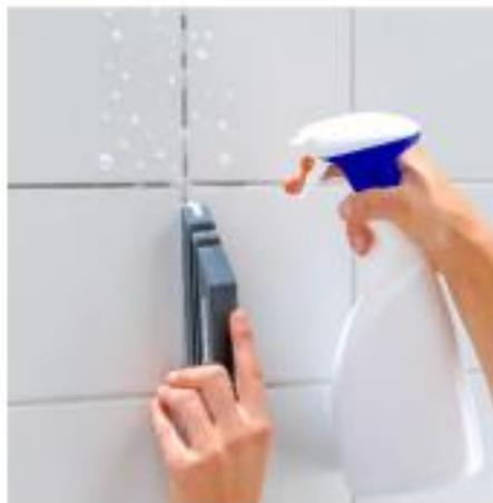
Reinigen Sie die Fugen mit der Fugenbürste, bis aller Schmutz abgelöst ist. Nehmen Sie das Reinigungsmittel mit einem feuchten Tuch auf und waschen Sie mit klarem Wasser nach. Die Reinigung ist abgeschlossen.
