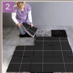
2. Alle Elemente auf der zuvor festgelegten Position umdrehen und alle Klettänder entfernen.
