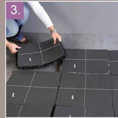
3. Jedes Element so drehen, dass alle Pfeile in eine Richtung zeigen.
